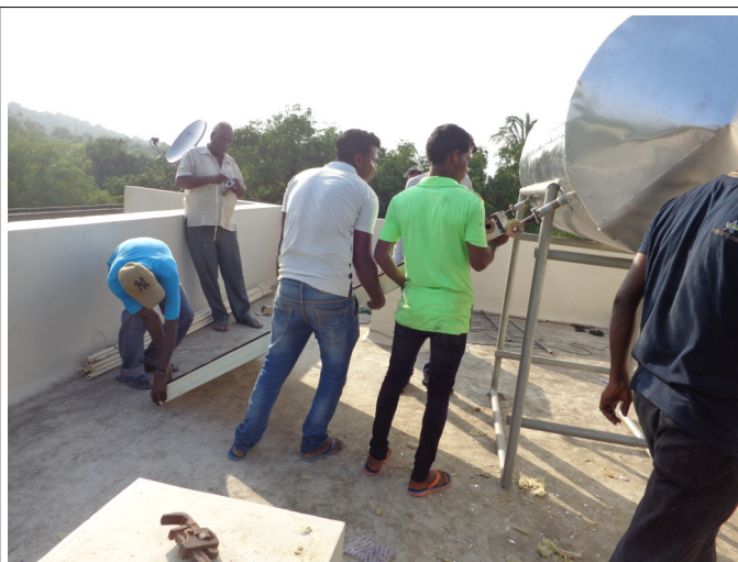
I lavori per l'installazione dell'impianto
